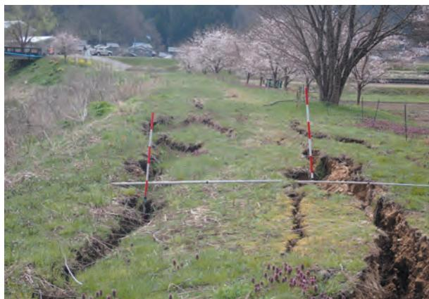
河川災害対応状況（地震災害後：堤防の亀裂状況）
