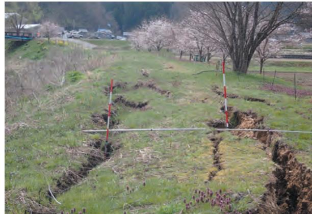
河川災害対応状況（地震災害後：堤防の亀裂状況）
