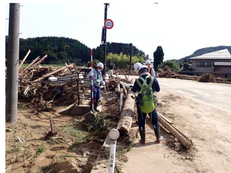
豪雨災害後の道路災害状況を調査
