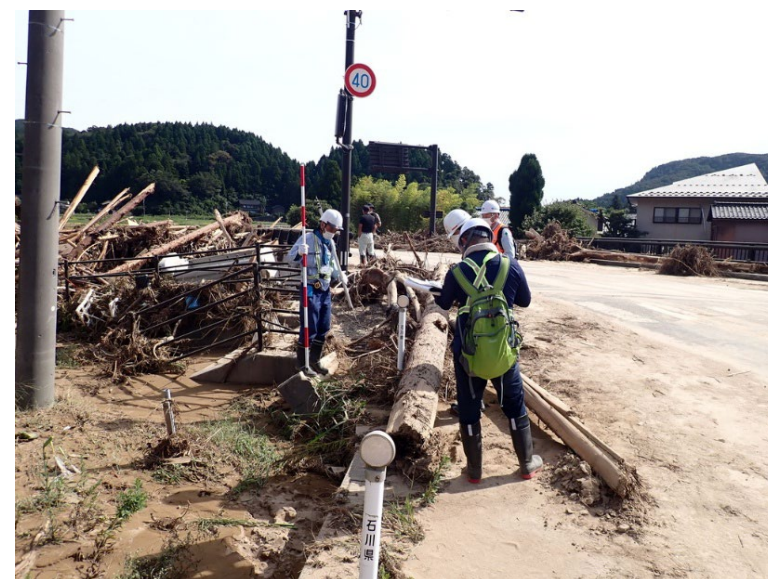
豪雨災害後の道路災害状況を調査
