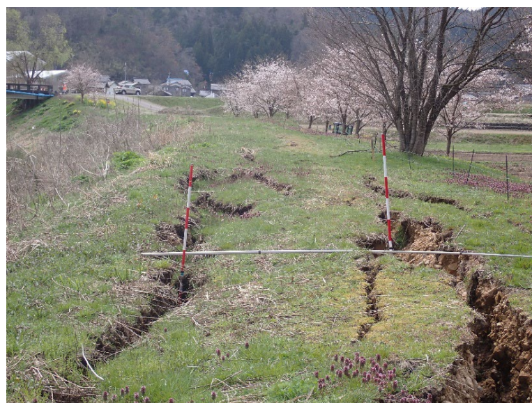
地震災害後の河川災害状況を調査
