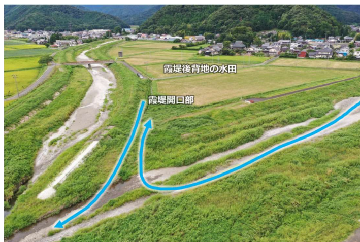
図1. 福井県北川流域の霞堤。洪水時には開口部から背後の水田に水がゆるやかに溢れる
