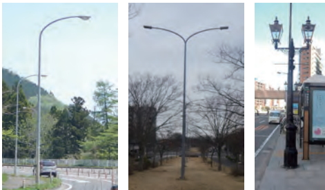
写真1 道路照明施設の例
