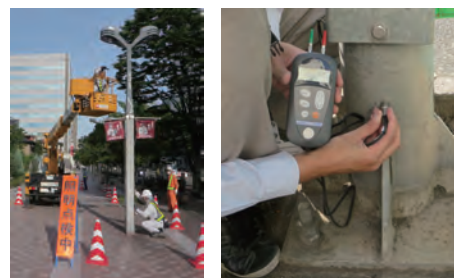
写真2 定期点検状況
