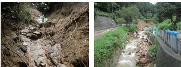
写真2 土砂流出状況
