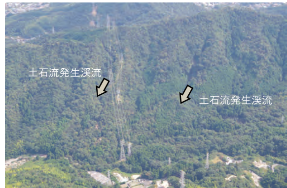
写真3 セスナ機による流域全体調査
