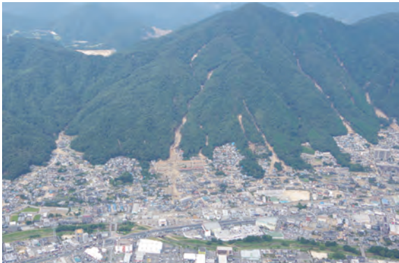
写真1 「平成26年8月豪雨」による土砂災害(八木・緑井地区)
