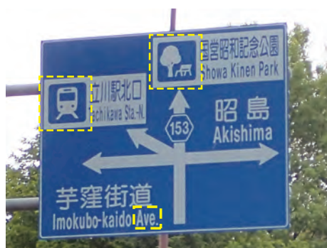
図5 改修後の方面および方向標識 (例1:英語併記・ピクトグラム標示)
