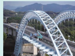
長大橋の点検
