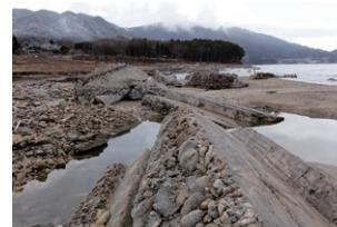
洗掘により倒壊した海岸堤防(南三陸町)
