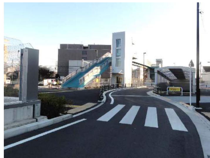
踏切を除去し、道路と鉄道を立体交差 歩行者のための横断歩道橋・エレベータを配備
