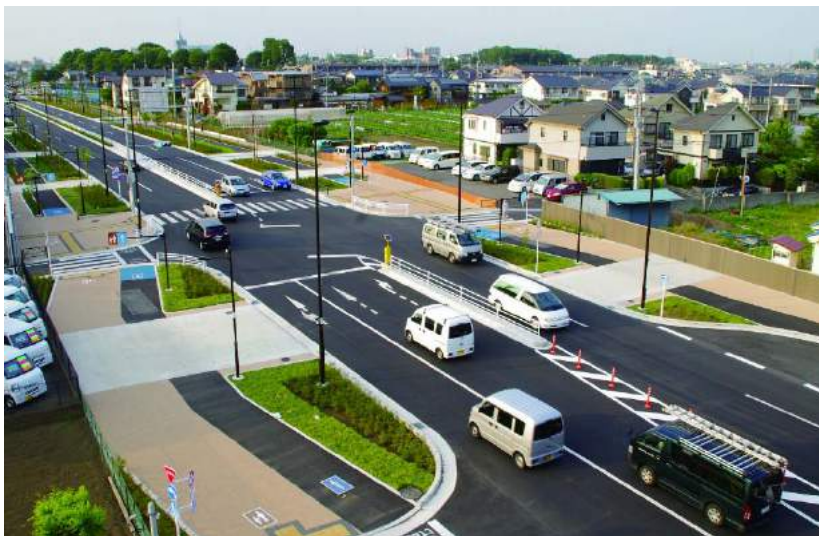
バリアフリー化・無電柱化された 快適な自転車・歩行者通行空間の整備
