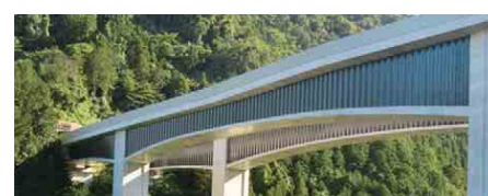
首都圏中央連絡自動車道のジャンクション橋
