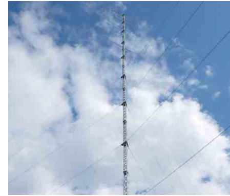
風況観測タワー
