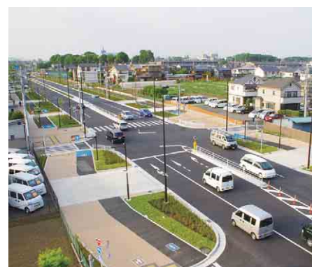
主要地方道の整備(無電柱化、バリアフリー化)
