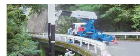
当社所有の橋梁点検車による点検・診断
